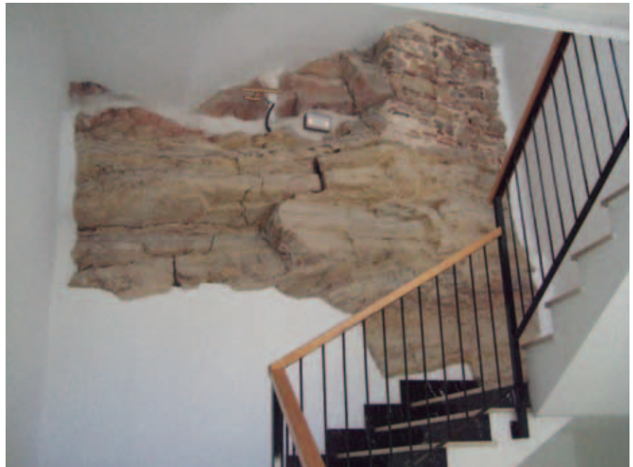
Figura 4. Afloramiento de finas alternancias de arenas y limos calcáreos correspondientes a depósitos intermareales cretácicos en la entreplanta del portal de la calle Cervantes, 17 (Calle Real). Foto: Andrés Díez.
