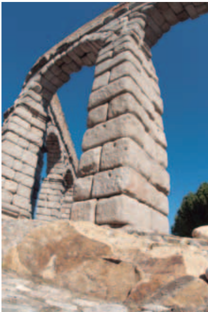
Figura 3. Afloramiento de granitoides aplíticos tardivariscos de dos micas en la base del acueducto a su paso por la plaza de Día Sanz (barrio de El Salvador). Foto: Ignacio Gutiérrez.
