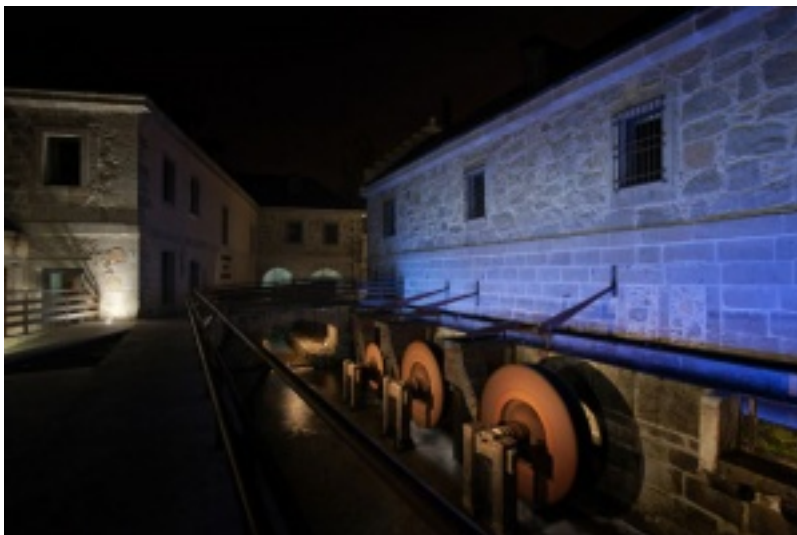
Patio de canales
